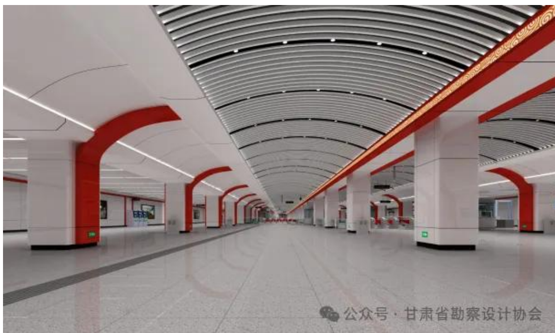
图 3 东方红广场站装修实景
