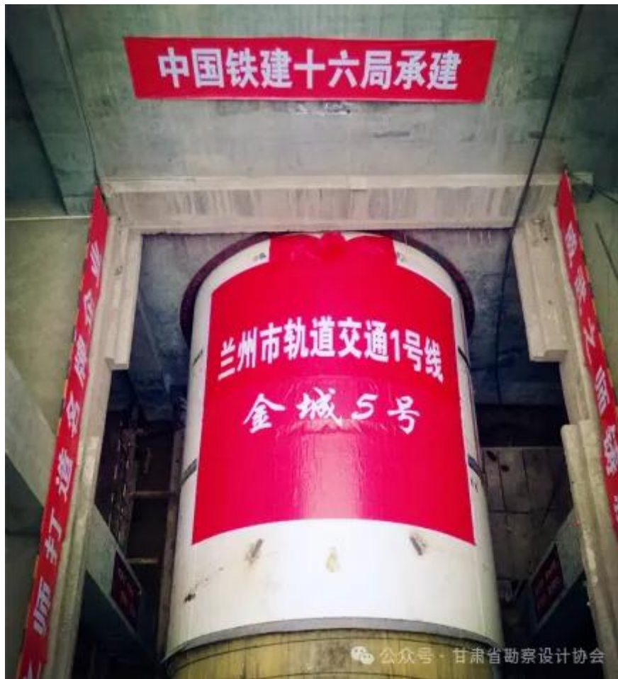
图3 下穿黄河盾构始发
