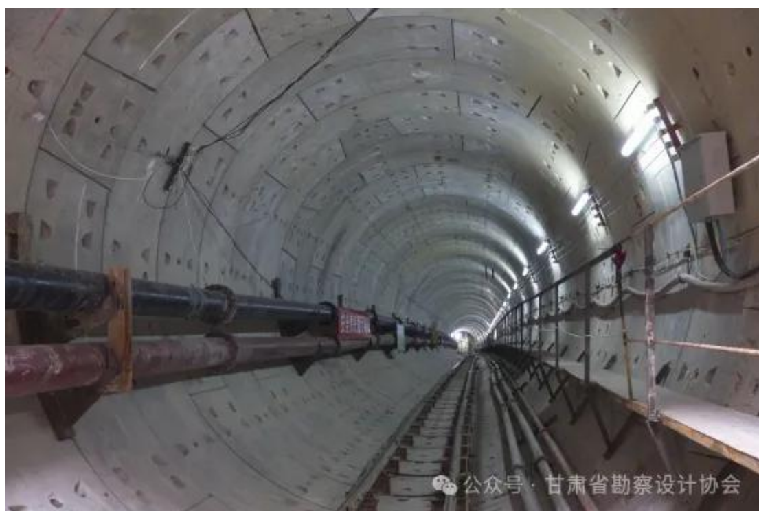
图8 下穿黄河成型隧道
